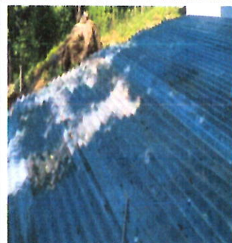
SUSTITUCION DE LAMINA EN COCINA
