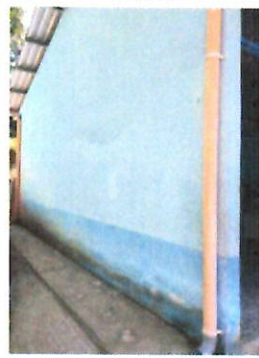
PINTURA APLICACIÓN DE PINTURA EN MUROS EXTERNOS E INTERNOS
