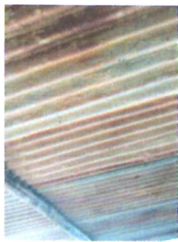
SUSTITUCION DE ESTRUCTURA DE TECHO
