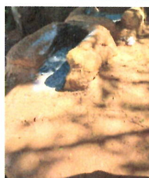
SUSTITUCION DE COCINA RURAL
